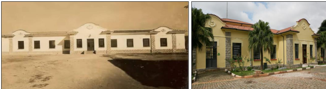
Figura 2.9 – Fotografia da ETA Guarará, Estação de tratamento de água
