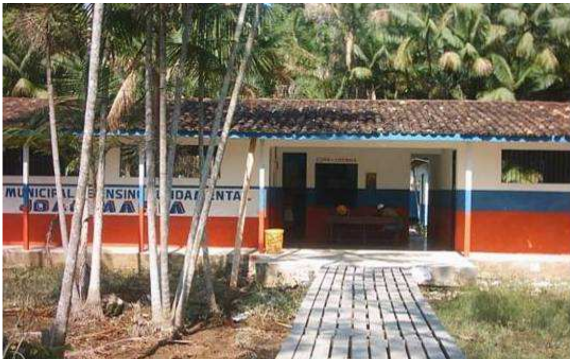
Figura 23: Vista frontal da Escola Municipal de Ensino Fundamental João Maria Fonte: Pesquisa de campo, 2009.
