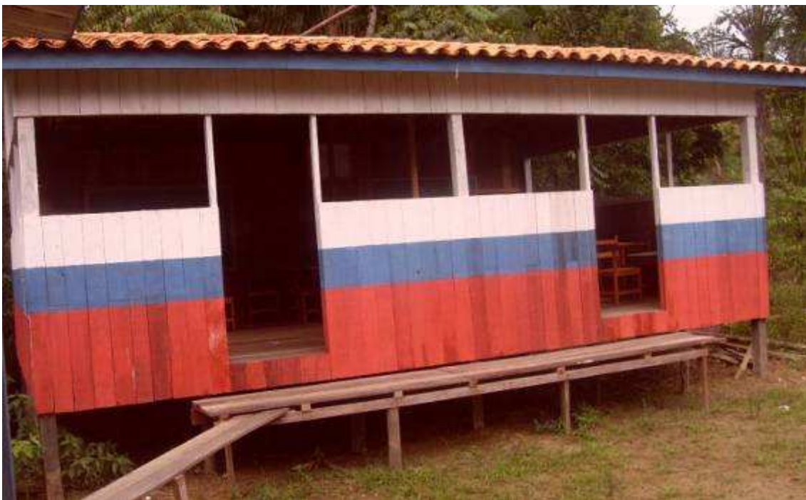
Figura 24: Salas de aula construídas em madeira, anexas à escola João Maria. Fonte: Pesquisa de campo, 2009.
