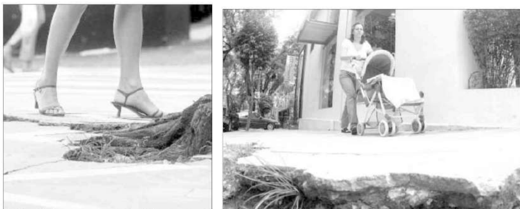
Figura 25 - Problemas nas calçadas da rua Oscar Freire.
