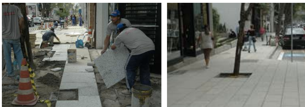
Figura 33 - Antes e depois da intervenção urbana realizada na rua Oscar Freire.
