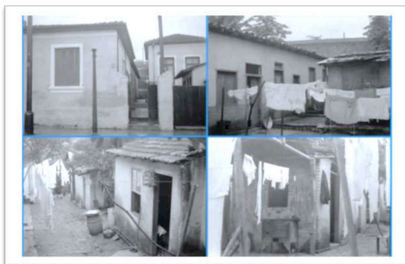
Figura 22 - Montagem com 4 imagens de cortiços na Rua Oscar Freire em 1938.
