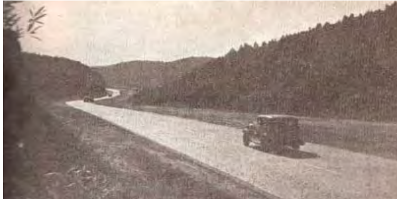
Figura 1.13 1948 Inauguração da Anhanguera - Km 17 - Trecho entre São Paulo e Jundiáí - Pavimento Concreto FONTE: BOLETIM DO DER V14 N50-51 1948
