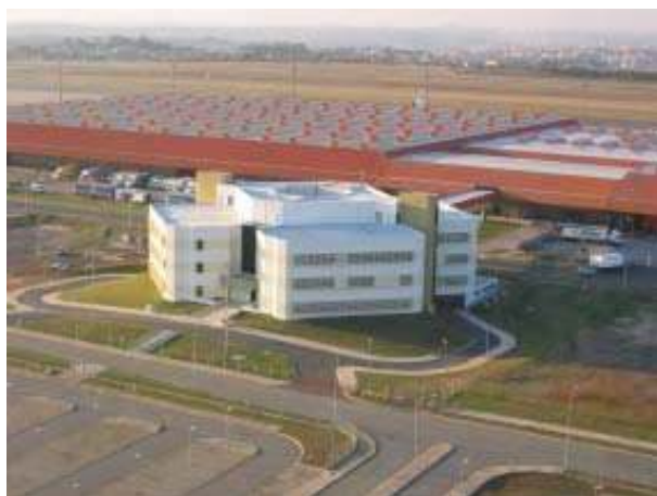
Figura XCIII – Vista geral da ligação entre o Prédio Administrativo (em primeiro plano) com o Edifício Anexo de Serviços do terminal de cargas de Viracopos. Foto: Maria Cristina Romaro, 2006.
