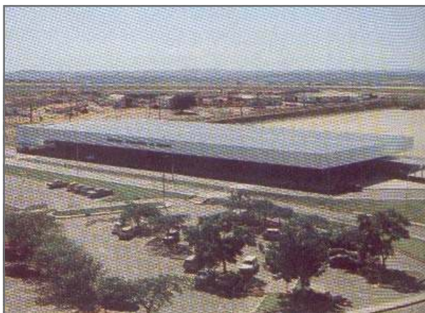
Figura LXXXVIII – Terminal de passageiros provisório. Fonte: SANTOS, 1985.
