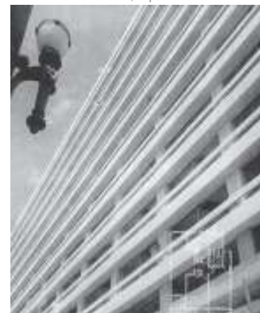
Figura 217: Edifício MARA. Rua Brigadeiro Tobias, 247, São Paulo, 1942. Fonte: L'architecture d'aujourd'hui – Brésil, 1952, nº. 42-43, s/p.
