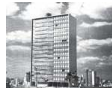
Figura 231: Edifício de Apartamentos Renato da Fonseca. Rua Antônio Carlos, 180, São Paulo, 1960. Arquitetos Eduardo Kneese de Mello e Joel Ramalho Jr. Fonte: Módulo, 1961, nº. 24, p. 34.
