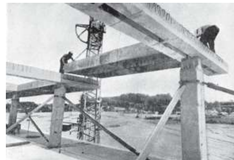
Figura 388: Detalhe da fase de montagem da estrutura pré-fabricada. Fonte: Revista do Diretório Acadêmico da Faculdade de Arquitetura Mackenzie, s/d, nº. 1, p. 48.
