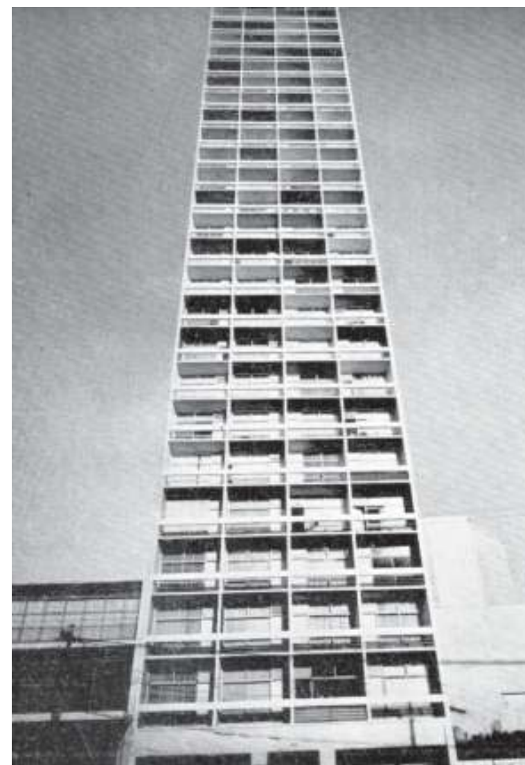
Figura 342: Edifício Icarai, 1955-1956. Praça Roosevelt, 128, Consolação, São Paulo. Arquiteto Franz Heep. Fonte: Acrópole, 1956, n.º. 234, p. 234.
