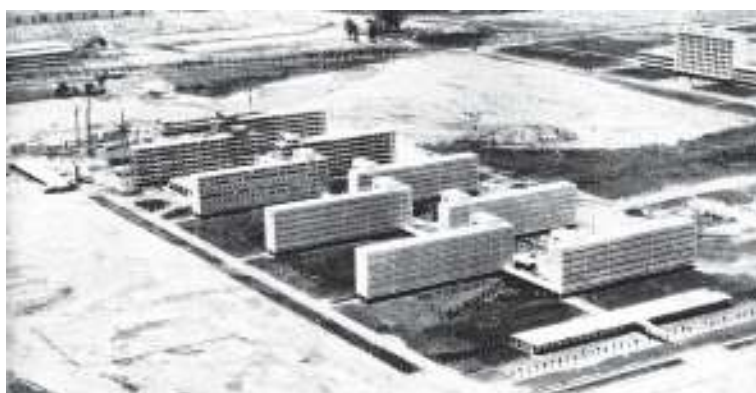
Figura 374: Vista aérea do conjunto com os seis primeiros blocos já executados em concreto convencional, e ao fundo, os restantes em execução com estrutura pré-fabricada. Fonte: Acrópole, 1964, nº. 303, p. 94.
