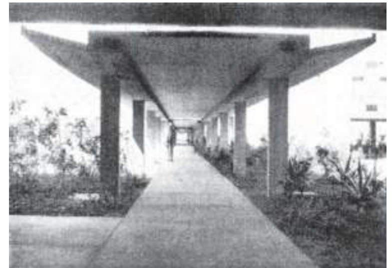
Figura 384: Vista do passeio coberto de ligação entre os edifícios. Fonte: Acrópole, 1964, nº. 303, p. 97.
