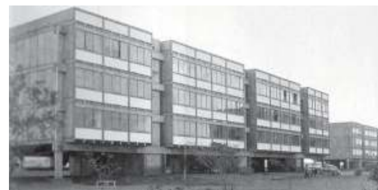
Figura 397: Vista geral do Conjunto Residencial para professores da Universidade de Brasília, 1962-1963. Arquiteto João Filgueiras Lima. Fonte: Acrópole 1970, nº. 369/ 370, p. 32.
