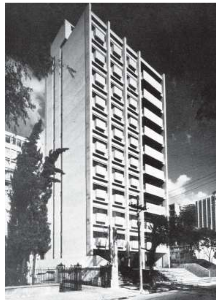
Figura 362: Edifício Maria Anna, 1961. Alameda Rio Claro, 251, Bela Vista, São Paulo. Arquitetos Maurício Kogan e Samuel Szpigel. Fonte: Acrópole, 1967, nº. 337, p. 22.
