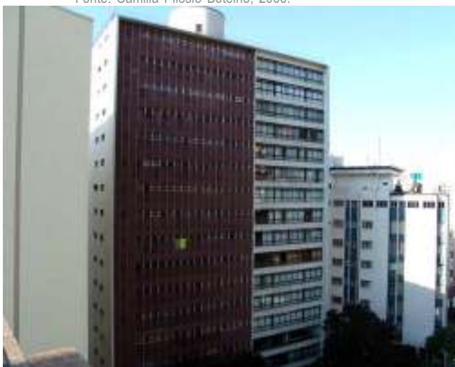
Figura 359: Fachada principal. Durante a construção, optou-se por colocar os elementos em madeira apenas em parte desta fachada, devido ao custo deste elemento. Fonte: Camilla Pilosio Botelho, 2006.
