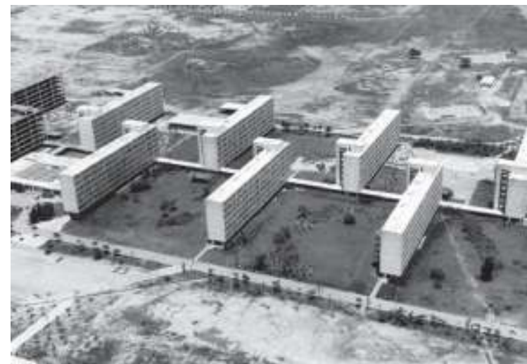
Figura 392: Vista do conjunto residencial parcialmente construído com o edifício da Antiga Reitoria ao fundo. Fonte: UNIVERSIDADE de São Paulo, 2005, p. 134.
