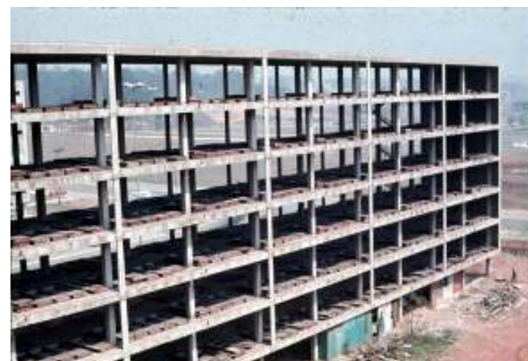
Figura 387: Detalhe da construção. Fonte: acervo FAU USP.
