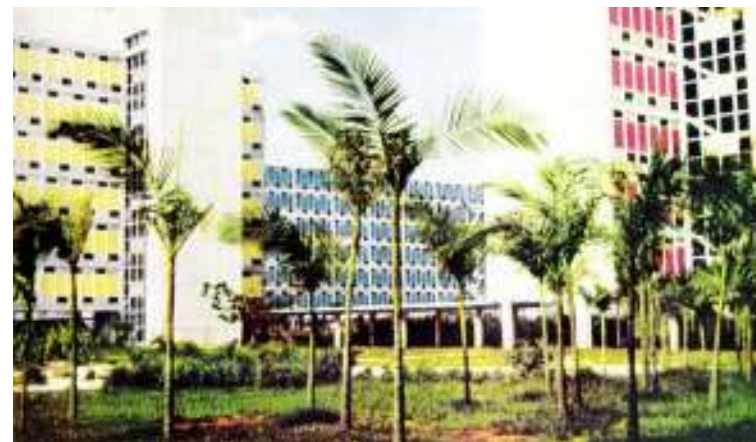
Figura 378: Detalhe dos edifícios recém construídos. Fonte: Acrópole, 1964, n°. 303, p. 93.
