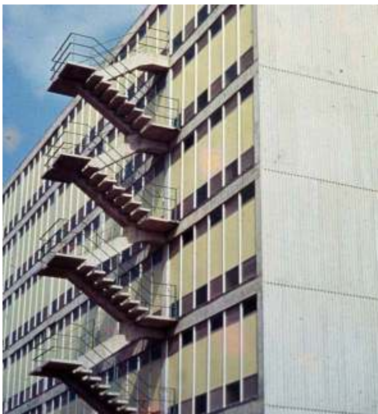
Figura 382: Detalhe da escada de emergência. Fonte: acervo FAU USP.
