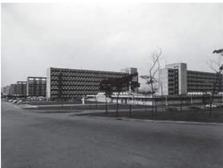
Figura 394: Vista do CRUSP, após sofrer alterações significativas, como a construção de edifícios com usos alheios no espaço antes destinado ao lazer dos estudantes e demolição de um dos edifícios. Fonte: acervo FAU USP.
