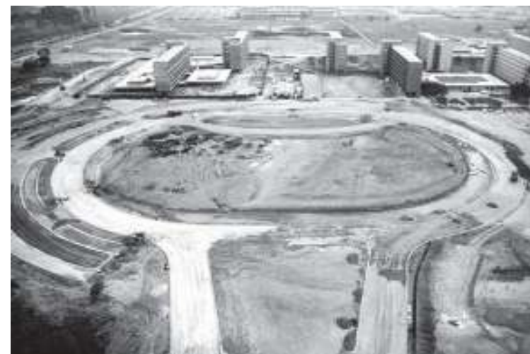
Figura 393: Obras do sistema viário de acesso à Reitoria e ao CRUSP. Para a execução dessas obras, um dos edifícios do conjunto foi demolido, desfigurando o projeto original. Fonte: UNIVERSIDADE de São Paulo, 2005, p. 142.
