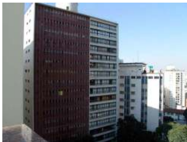
Figura 358: Fachada principal e lateral. Aberturas nas empenas laterais podem ser notadas, apesar de não estarem previstas no projeto original. Fonte: Camilla Pilosio Botelho, 2006.
