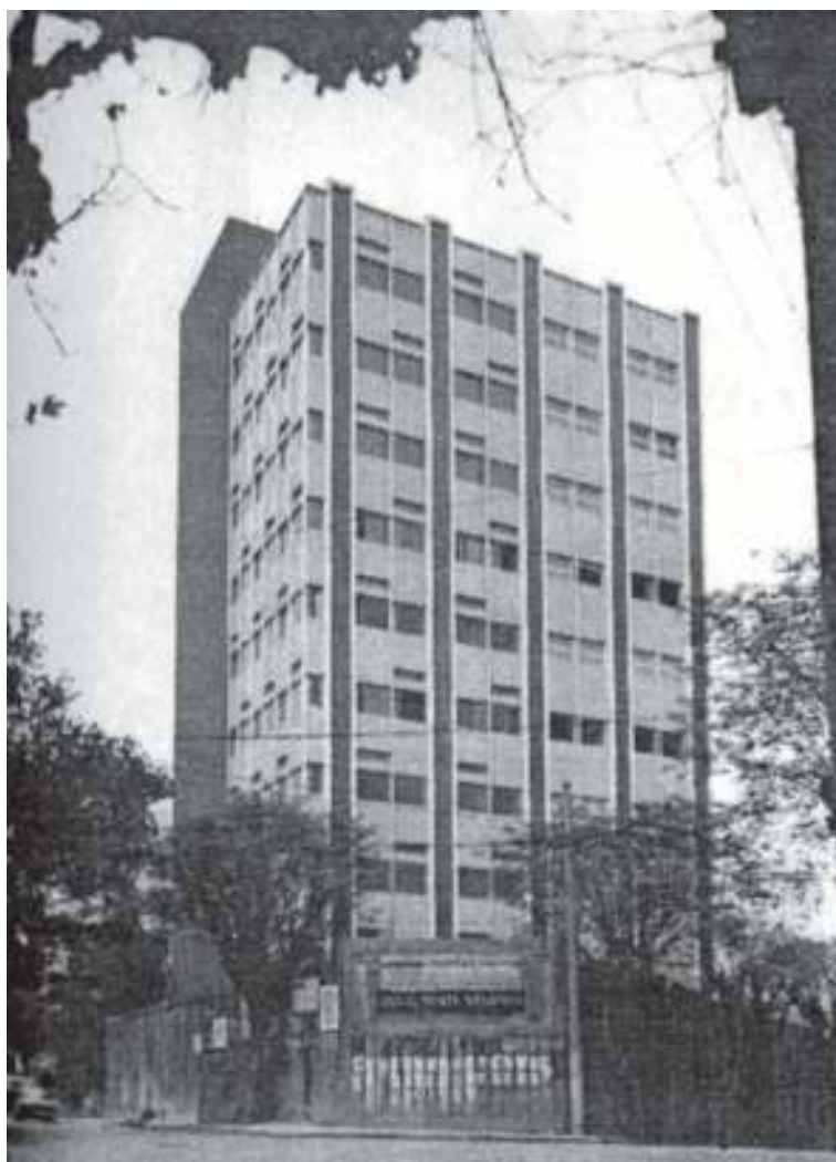
Figura 361: Edifício Araba, 1960-1962. Rua Aracajú, 235, Higienópolis, São Paulo. Arquiteto David Libeskind. Fonte: ROSALES, 2002, P4.F05.
