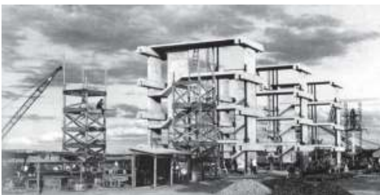
Figura 396: Conjuntos de circulação vertical fundidos no local da construção do Conjunto Residencial para professores da Universidade de Brasília, 1962-1963. Arquiteto João Filgueiras Lima. Fonte: LATORRACA, 1999, p. 37.
