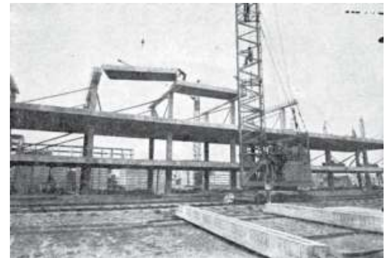
Figura 389: Detalhe da fase de montagem da estrutura pré-fabricada.
