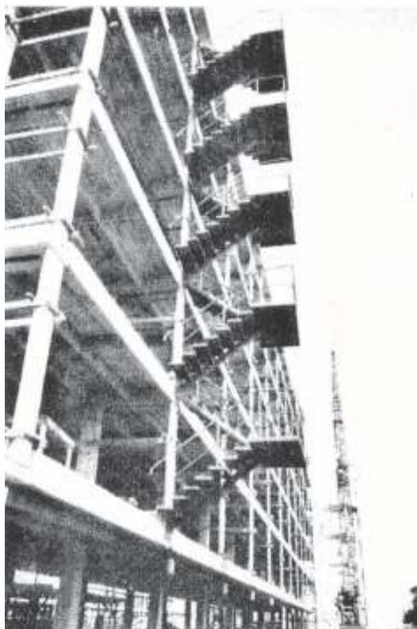
Figura 390: Detalhe da fase de montagem da estrutura pré-fabricada. Fonte: Revista do Diretório Acadêmico da Faculdade de Arquitetura Mackenzie, s/d, nº. 1, p. 47.
