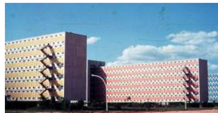
Figura 376: Fachada posterior dos primeiros blocos construídos. Nota-se a escada de emergência e o térreo aberto em pilotis. Fonte: acervo FAU USP.
