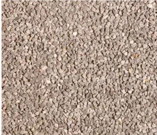
Figura 4 - Piso permeável em concreto poroso
