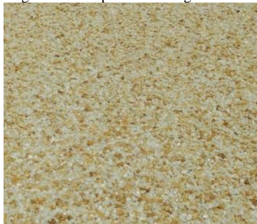
Figura 5 - Piso permeável fulget resinado
