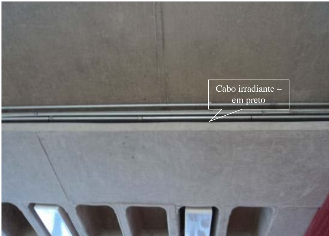
Fotografia 3 — Cabo irradiante instalado no teto do hall do prédio (60) T
