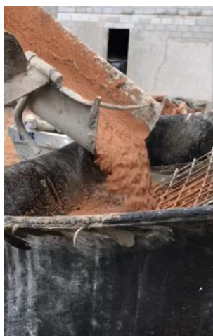
Figura 15 – Lançamento de Concreto Via Bomba Estacionária Fonte: Autor, 2019
