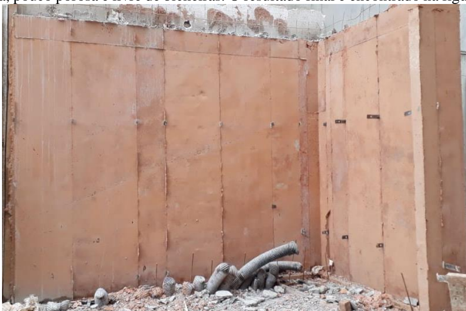
Figura 21 – Resultado da Parede de Concreto Colorido
