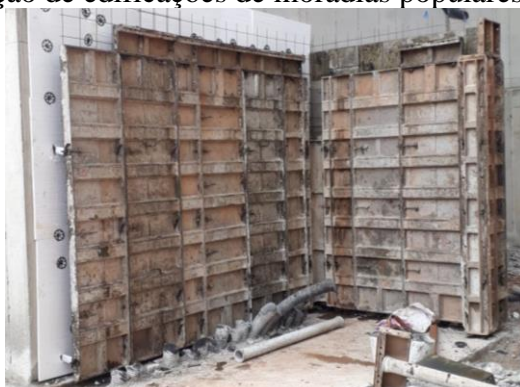
Figura 10 – Forma Metálica em Processo de Montagem em Obra Fonte: Autor, 2019
