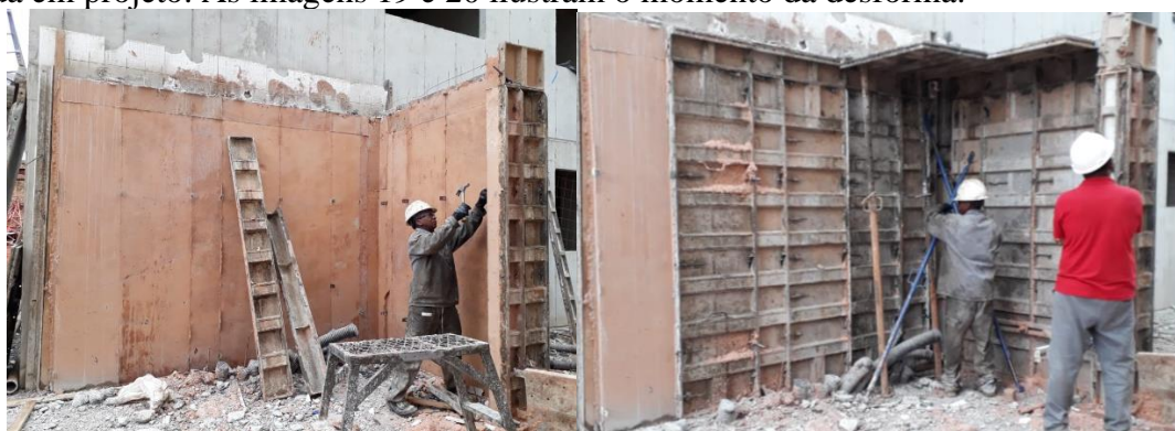
Figura 19 e 20 – Equipe de Obra Realizando a Desforma da Parede de Concreto Colorido
