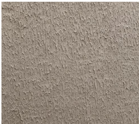
Figura 9 – Acabamento de Fachada Realizado em Obra Fonte: Autor, 2019
