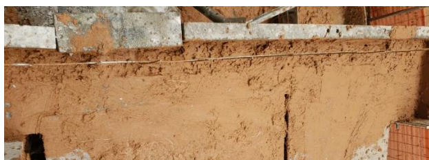
Figura 18 – Finalização da Concretagem Fonte: Autor, 2019.
