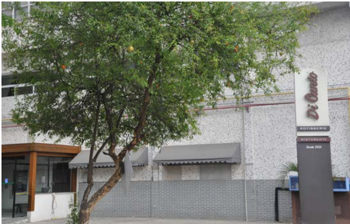
Fachada do casarão da família Di Cunto e atual espaço da rotisserie italiana
