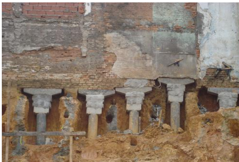
Figura 1 – Estacas Mega de concreto
