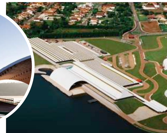
Entrada de luz natural no bloco circular, Brasília, BRA. Fonte: www.vitruvius.com .
