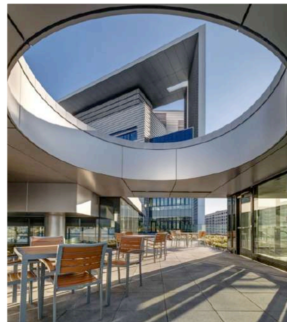
Diversas vistas do terraço, Spaulding Rehabilitation Hospital , Massachusetts, EUA. Fonte: www.archdaily.com .
