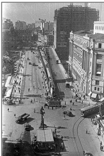
Figura 2.26: Os dois viadutos do Chá lado a lado. O antigo, de metal e madeira, com obras iniciadas em 1888, e o novo, de concreto armado, inaugurado em 1938.
