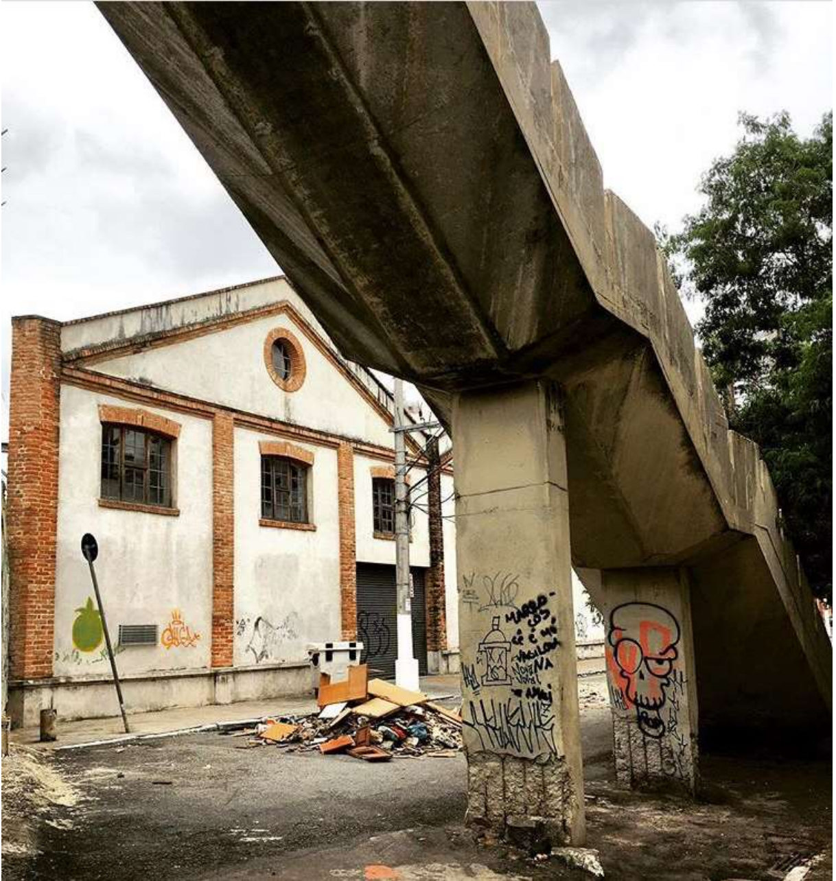
Figura 34. Atual sede do Poupatempo Lapa na Rua do Curtume. O topônimo faz referência às atividades de beneficiamento de couro, ocorridas antigamente no edifício de tijolos aparentes. A presença da passarela evidencia outra marca da ferrovia na paisagem. Fonte: acervo do autor, 2017
