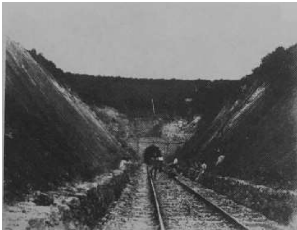
Figura 12. Túnel na Serra do Botujuru (1867) Fonte: Cyrino (2004)
