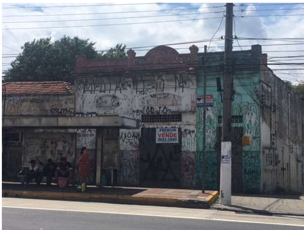
Figura 33. Construção na Rua Guaicurus, altura da Rua Duílio Notam-se traços de uma arquitetura comum no século XIX e início do século XX, com a presença de ornamentos na fachada
