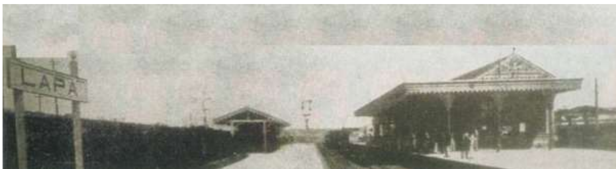
Figura 22. Estação da Lapa, em 1899. Fonte: acervo do autor
