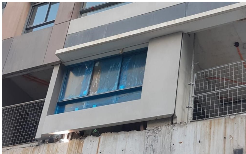
Figura 4 – Instalação do painel com caixilho previamente fixado
