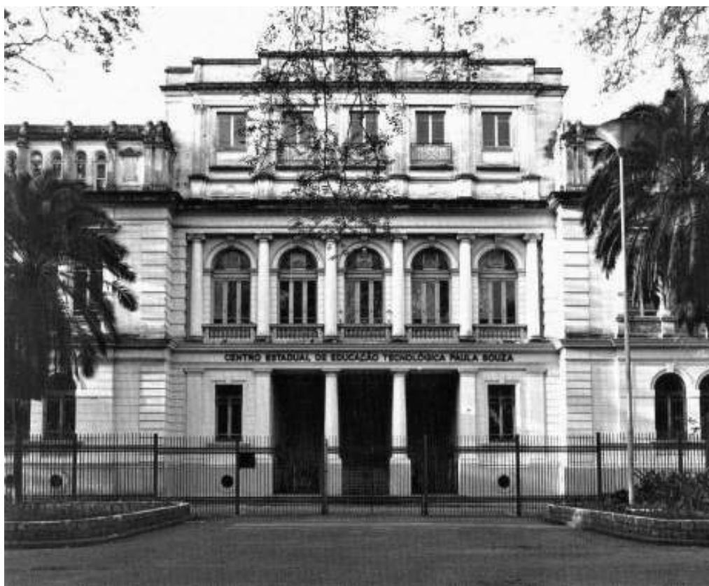
a presença de um ecletismo eloqüente nos principais edifícios públicos de São Paulo Fig. 25 – projeto de Ramos de Azevedo – Laboratório da escola Politécnica
