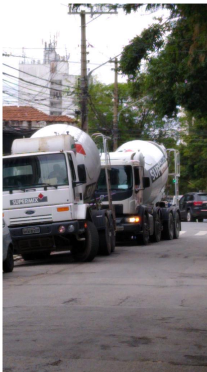
Figura 11 – Betoneiras enfileiradas aguardando para descarga
