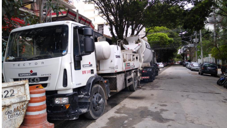
Figura 12 – Bomba estacionária de concreto
