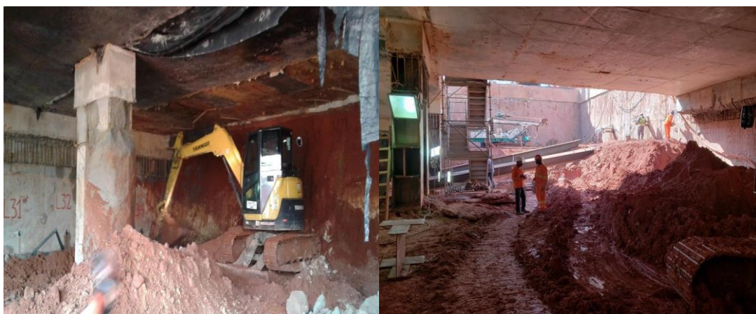
Figura 2 – Etapas de escavação da vala e perfuração das paredes diafragmas
