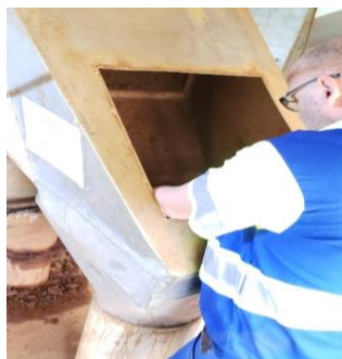
Figura 4 - Detalhe da abertura do duto de onde foi retirado o lodo.
