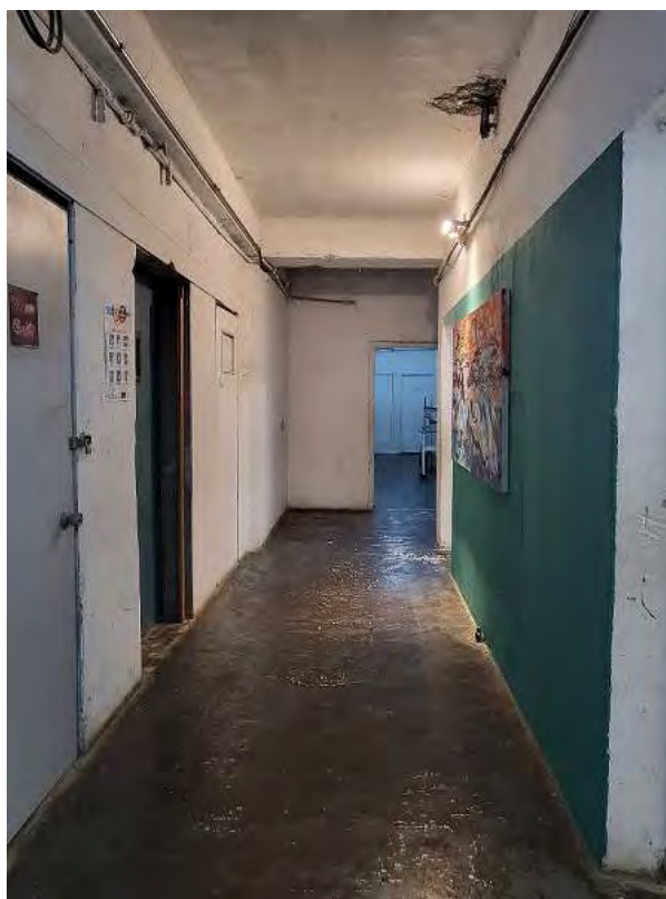
Figura 19 – Interior da Ocupação 9 de Julho
