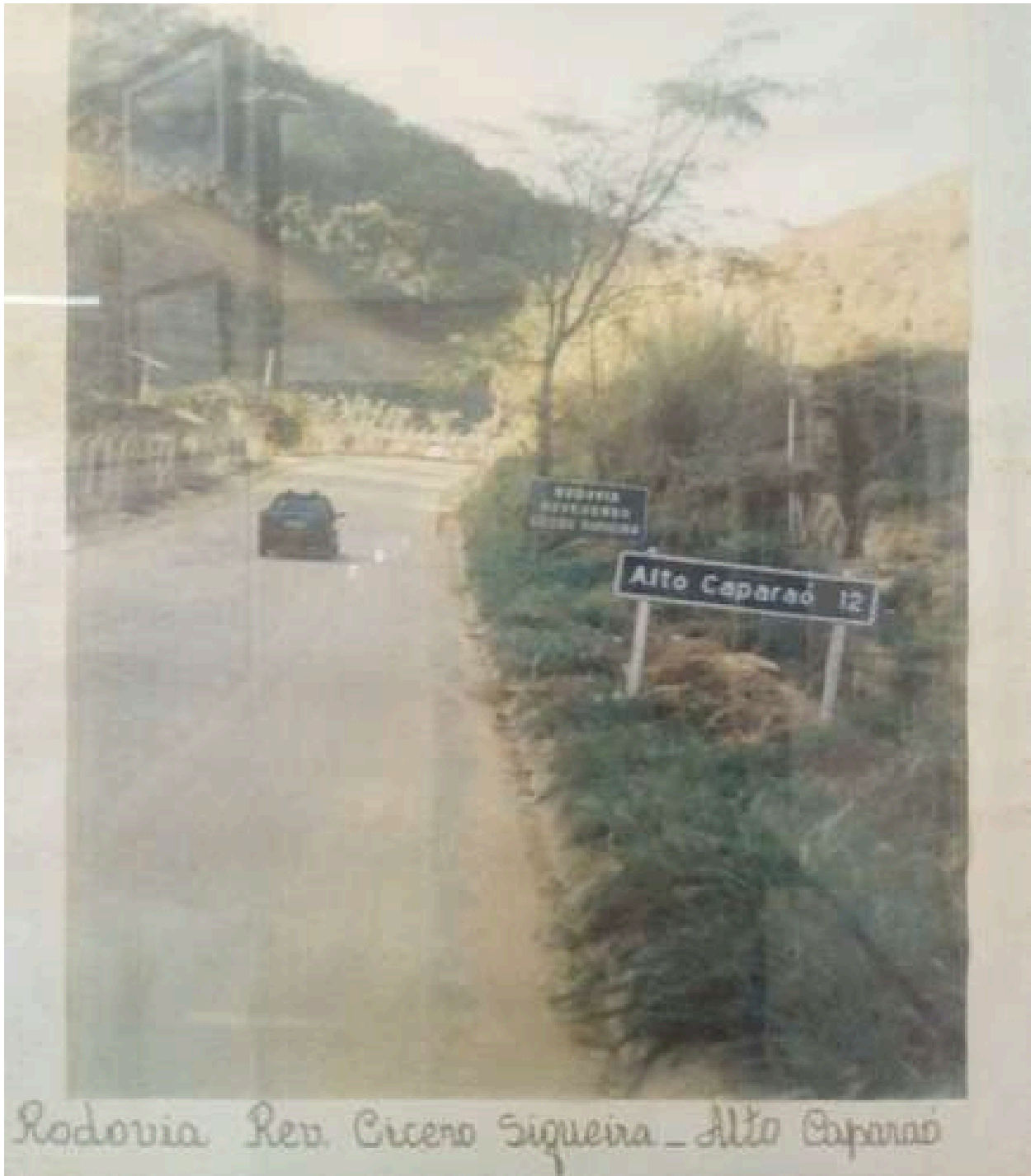
Figura 62: Rodovia Rev. Cícero Siqueira.
