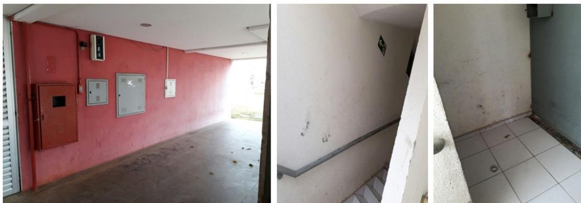
Figura 38 e 39: Paredes internas da área comum - conjunto habitacional Heliópolis I.
