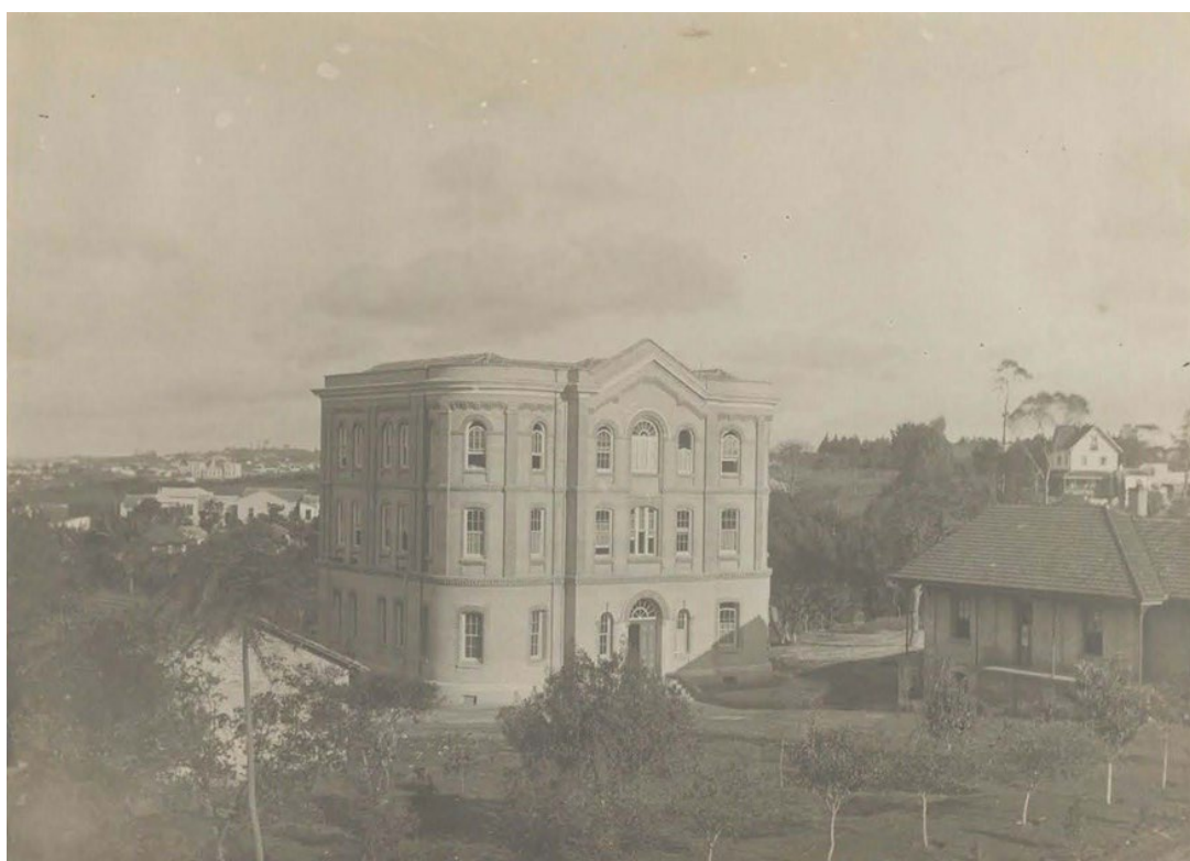
Figura 5 – Dormitório Masculino dos Adultos e Fragmento da Primeira Edificação do campus de 1901
