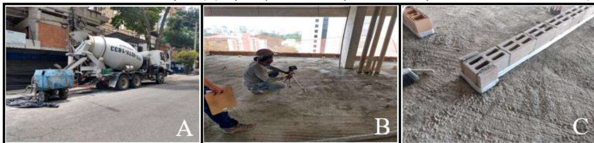
Figura 4 - Preparação da entrada da obra 1 para o recebimento do material (A); mapeamento do local para a conferência do nível do contrapiso (B); aplicação da fita de polietileno na primeira fiada de alvenaria (C)
