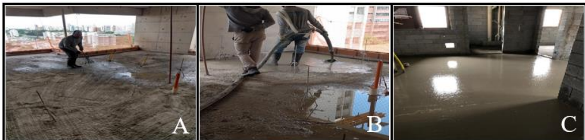
Figura 6 - Distribuição das niveletas (A) e lançamento da argamassa (B) na obra 1 e cura do contrapiso (C) na obra 3
