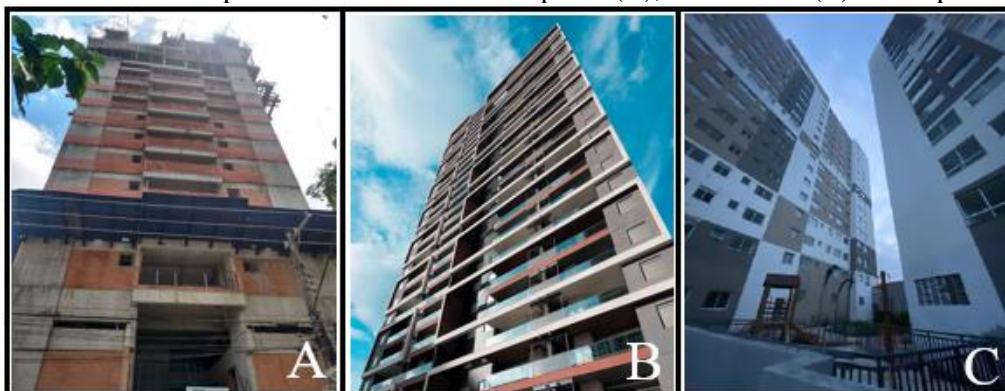
Figura 3 - Fachadas dos empreendimentos: Omni Ibirapuera (A), Habitarte II (B) e Complexo Mauá (C)
