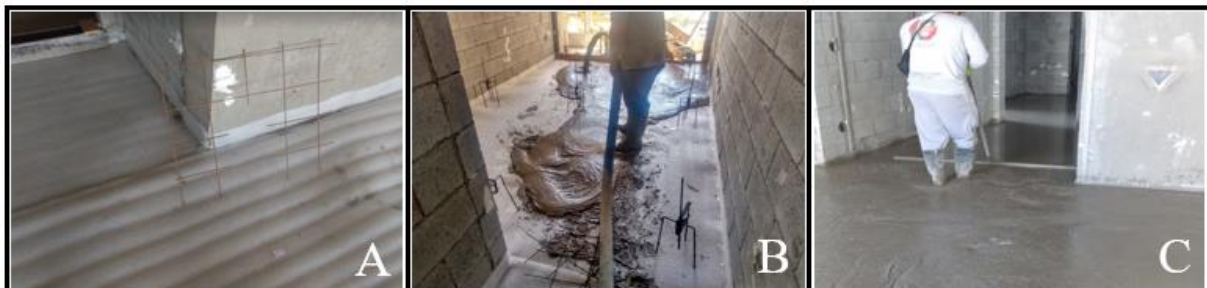
Figura 5 - Aplicação da manta acústica e posicionamento da tela metálica (A), aplicação da argamassa (B) e acabamento com a membrana (C)
