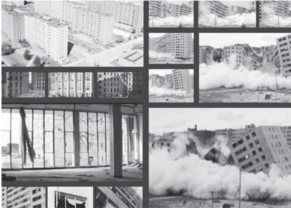
Figura 12: Imagens da Destruição do Conjunto Pruitt-Igoe - St. Louis, EUA, 15/07/1992 Fonte: http://arquiteturadocaos.blogspot.com.br/2009/10/minoru-yamasaki-o-arquiteto-do-po.html
