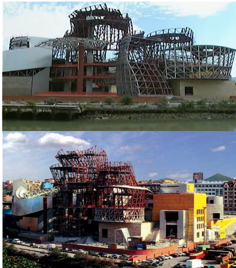
Figura 33: Estrutura pré-proposta pelo CATIA e dimensionada pelos profissionais da IDOM e CMG para o Museu Guggenheim – 1991
