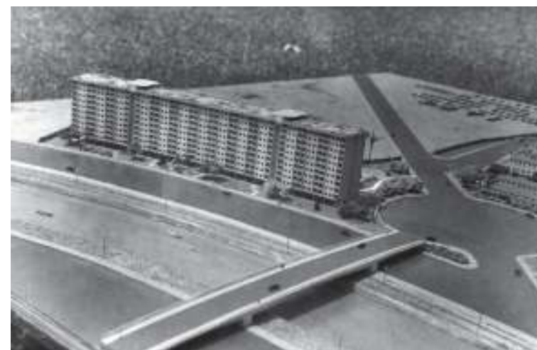
Figura 278: Detalhe do edifício residencial laminar. Fonte: acervo Unicentro.
