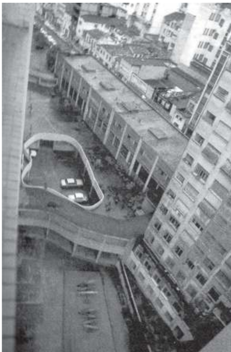
Figura 303: Galeria suspensa de acesso ao edifício e área comum entre este e o bloco comercial. Fonte: BONDUKI, 1998, p. 199.
