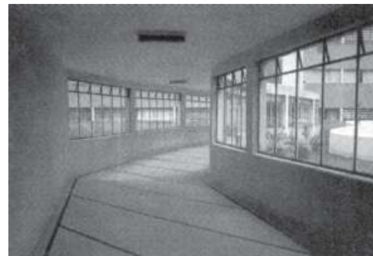
Figura 302: Vista interna da galeria suspensa de acesso ao edifício. Fonte: BONDUKI, 1998, p. 199.
