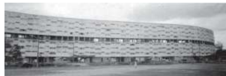
Figura 308: Edifício serpenteante do conjunto residencial Deodoro, Rio de Janeiro, 1954. Projeto do arquiteto Flávio Marinho Rego. Fonte: BONDUKI, 1998, p. 196.
