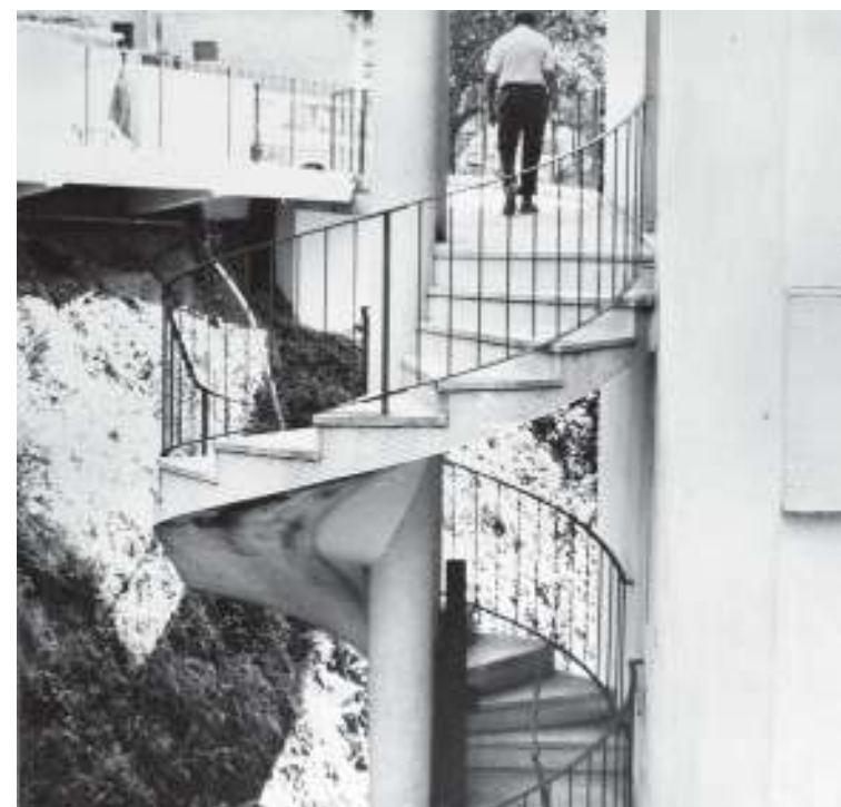
Figura 329: Escada externa de acesso aos demais pavimentos do edifício Hicatu. Fonte: acervo FAU USP.
