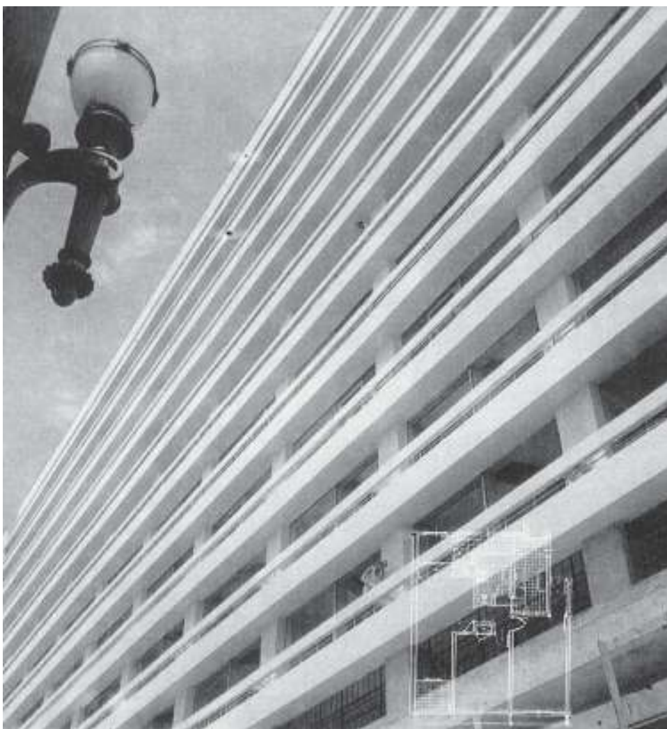
Figura 241: Vista da fachada principal onde nota-se a presença dos terraços e jardineiras. Fonte: THOMAZ, 1992/ 1993, p. 82.
