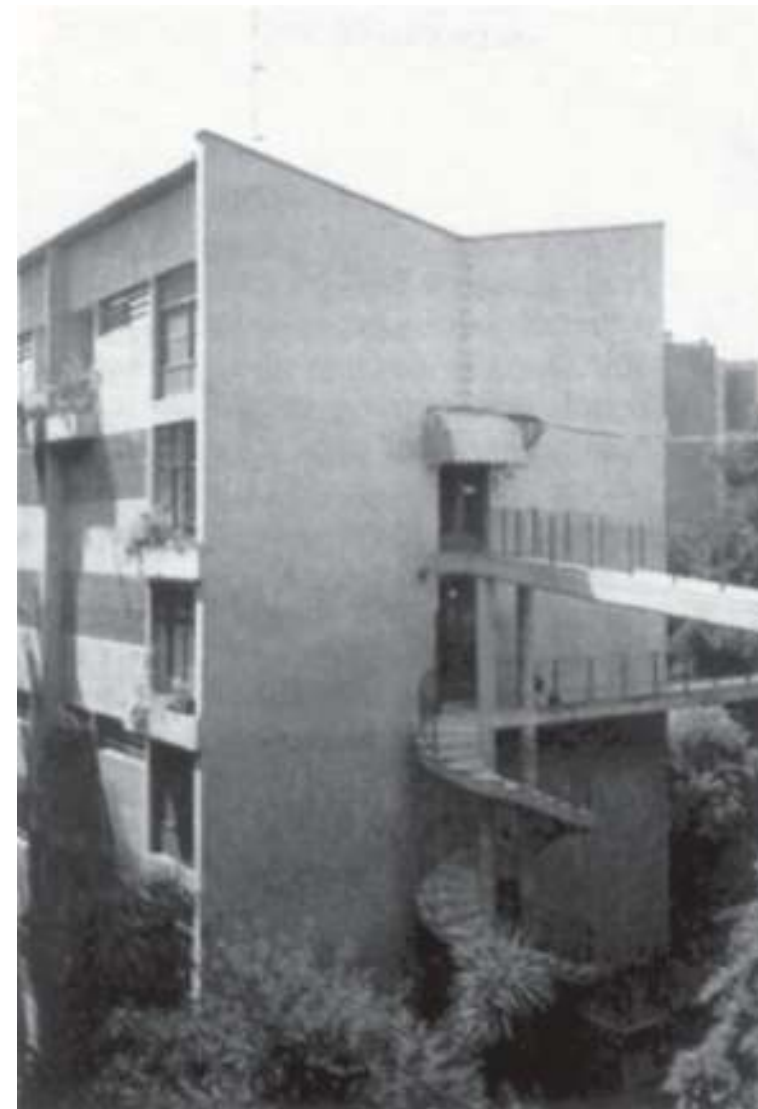
Figura 327: Fachada lateral e principal do edifício Hicatu. Fonte: THOMAZ, 1992/ 1993, p. 87.
