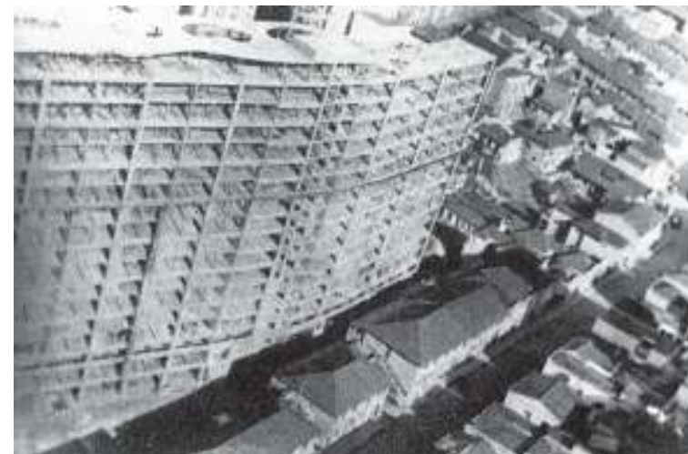
Figura 300: Edifício Japurá em construção na década de 1950. Fonte: BONDUKI, 1998, p. 198.
