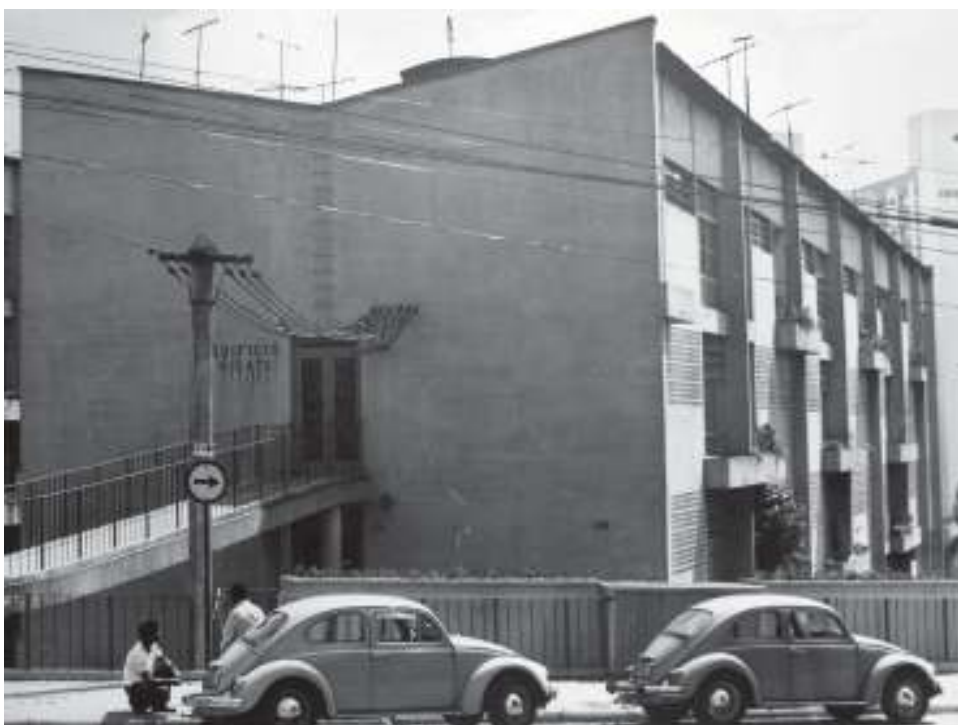
Figura 328: Acesso principal do edifício Hicatu e fachada lateral. Fonte: acervo FAU USP.
