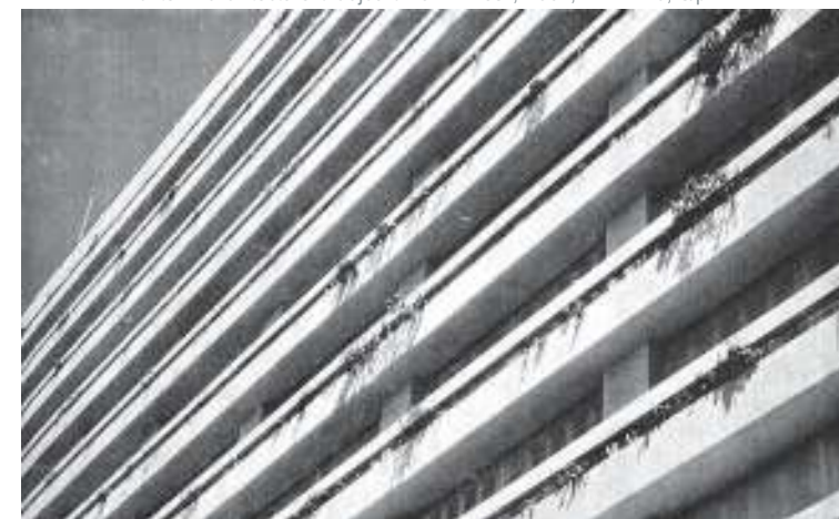
Figura 243: Detalhe fachada principal composta, em toda sua extensão, por jardineiras. Fonte: L'architecture d'aujourd'hui – Brésil, 1952, n°. 42-43, s/p.
