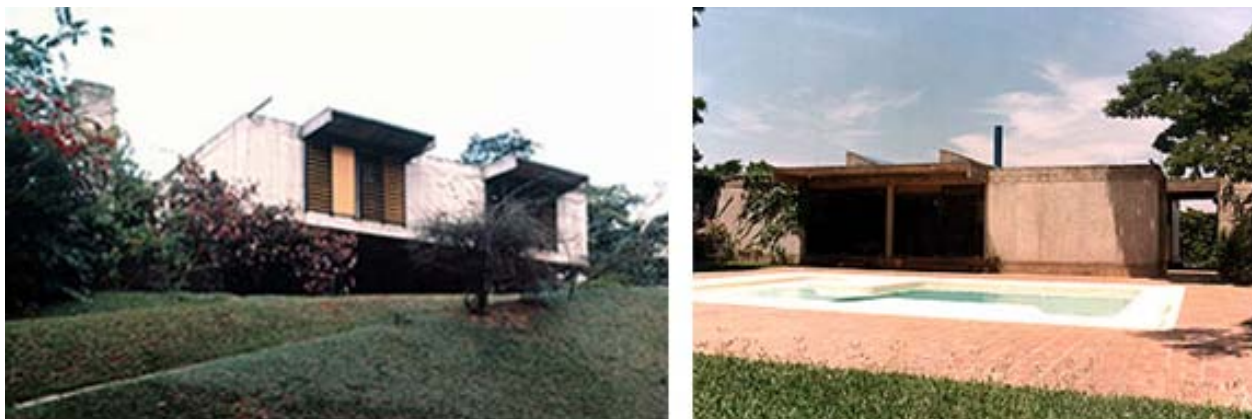
Fig.4. Residência no Morumbi (1974), projeto de Carlos Bratke e Renato Lenci. Fonte: http://www.carlosbratke.com.br/
