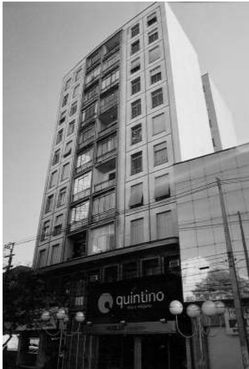
Fig. 15 - Edifício Santo Antônio (1950)
