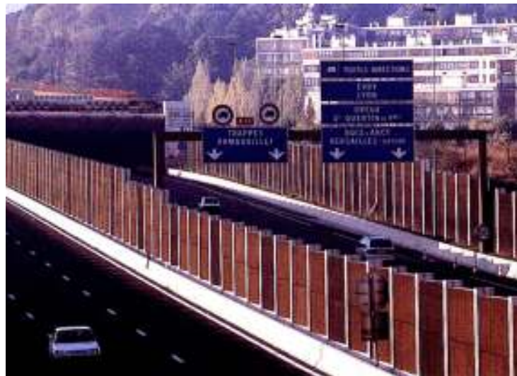
Figura 63 Barreira nos dois lados da rodovia, paralelas entre si.
