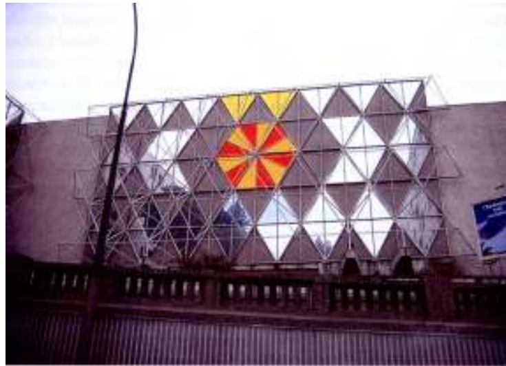
Figura 57 Barreira com 20m de altura protegendo uma área residencial na Périphérique, em Paris.
