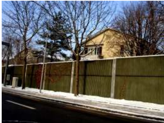
Figura 59 Barreira com elementos repetitivos.
