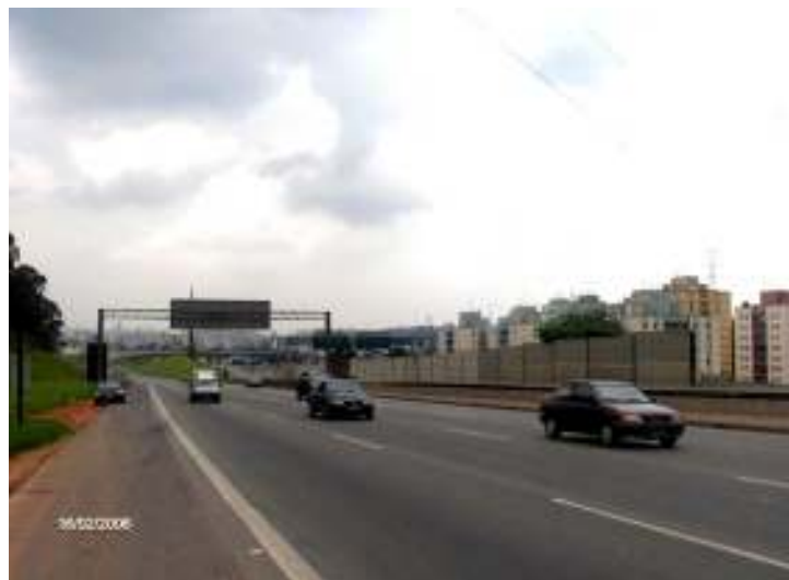
Figura 76 Talude paralelo a barreira instalada na rodovia dos Bandeirantes, em São Paulo.
