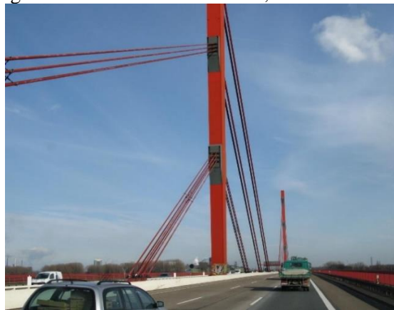
Figura 6 — Ponte Beeckerwerth, sobre o rio Reno
