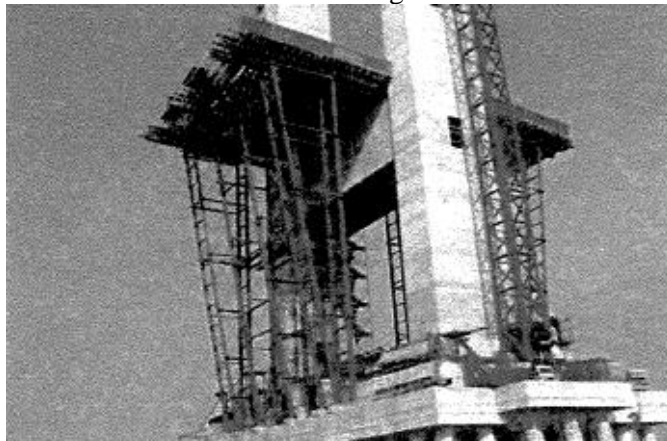
Figura 13 — Cimbramento no início da montagem do tabuleiro da Ponte sobre o Rio Guamá
