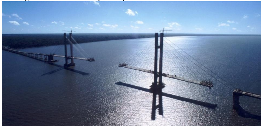
Figura 16 — Construção da ponte estaiada sobre o Rio Guamá
