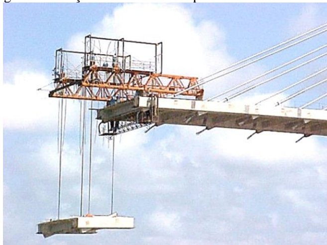
Figura 14 — Içamento de aduelas ponte sobre o Rio Guamá
