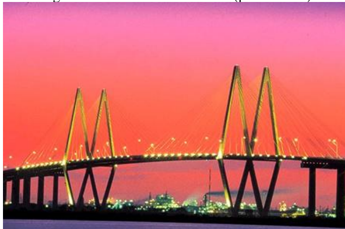
Figura 9 — Ponte Fred Hartman (pórtico “A”)
