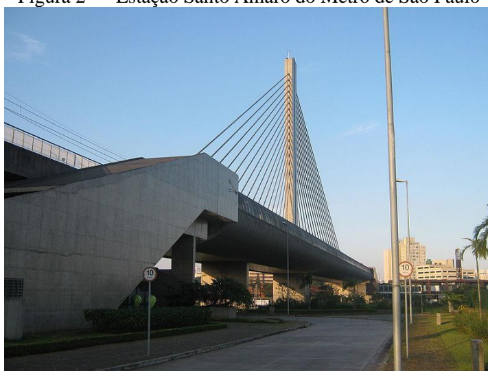
Figura 2 — Estação Santo Amaro do Metrô de São Paulo
