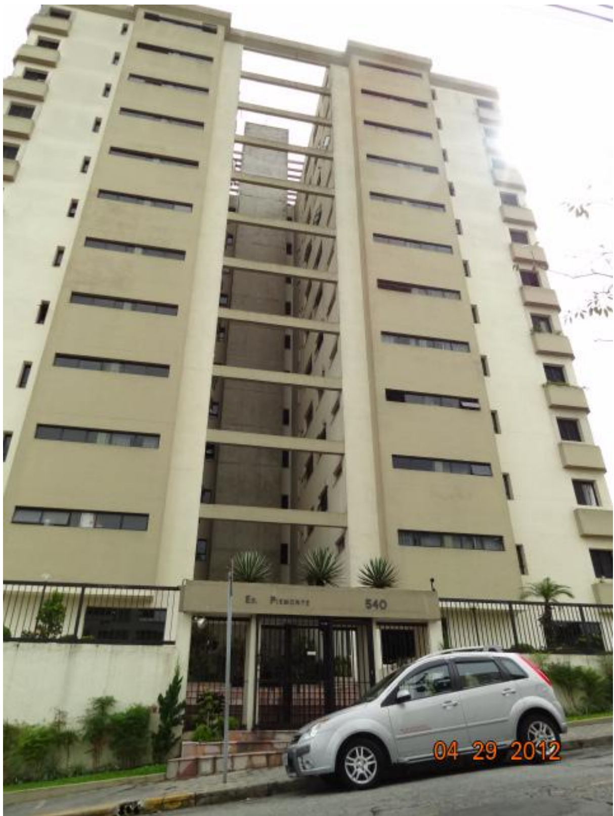
Fotografia 3: Fachada frontal do Edifício Piemonte
