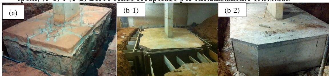
Figura 3 – Recuperação do bloco de fundação. (a) Bloco pronto para receber injeção de resina epóxi; (b-1) e (b-2) Bloco sendo recuperado por encamisamento estrutural.
