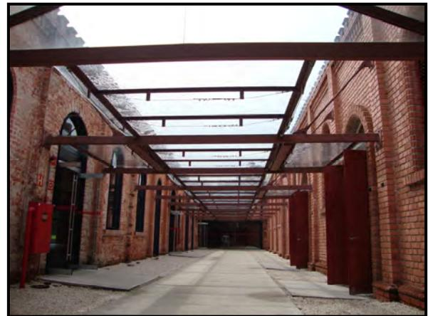
**Cobertura de vidro, fixada por tirantes à alvenaria, que permite a conexão entre os galpões**
