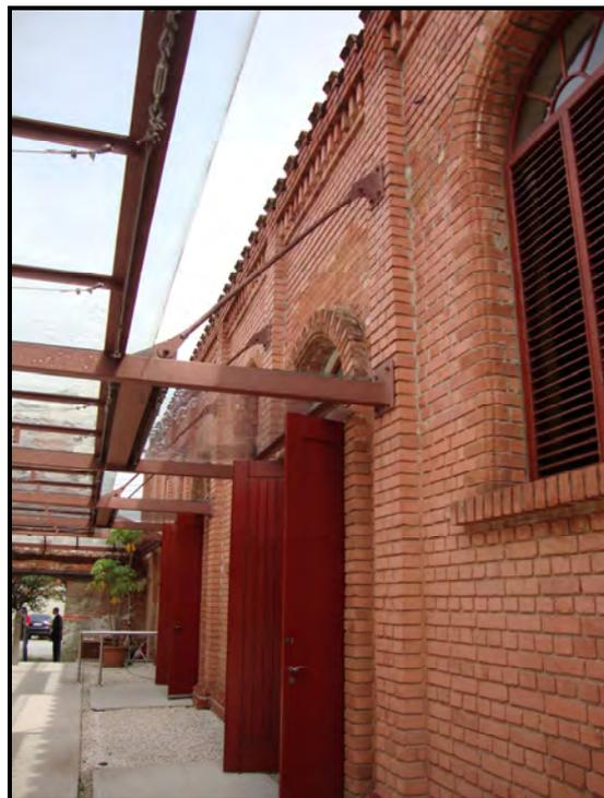
**Cobertura de vidro, fixada por tirantes à alvenaria, que permite a conexão entre os galpões**
