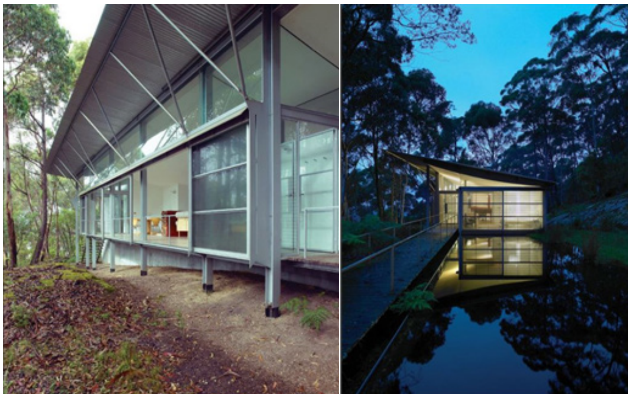
Figura 16 – janelas deslizantes e acesso à Casa Simpson – Lee
