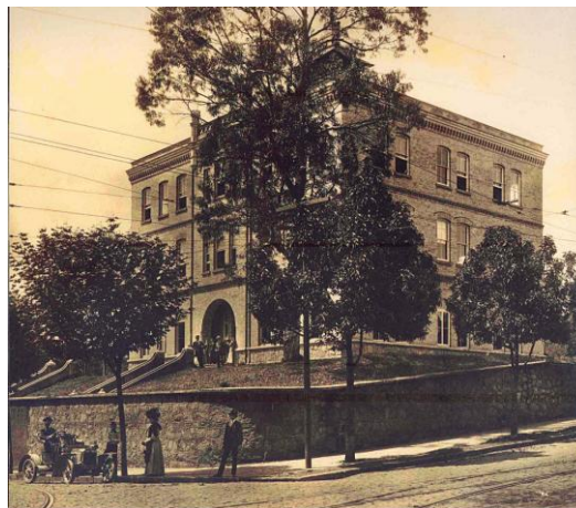
Figura 1. Edifício Mackenzie nas esquinas das ruas Itambé e Maria Antônia. Fonte: Centro Histórico Mackenzie
