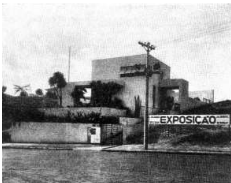
o convite à população para que entrassem em contato com a nova arquitetura Fig. 34 – foto da época com faixa referente à Exposição de uma Casa Modernista
