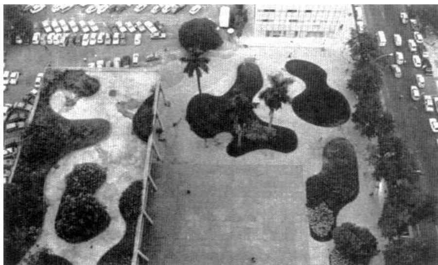
o jardim tropical que emoldura o edifício público Fig. 56 – projeto paisagístico de Roberto Burle Marx
