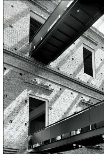
Vista interna das passarelas que cruzam os pátios
