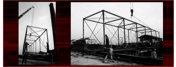
Construção das estruturas na Matarazzo
