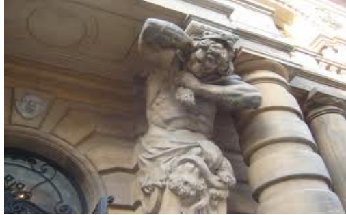
Figura 8 Detalhe da Fachada do Teatro
