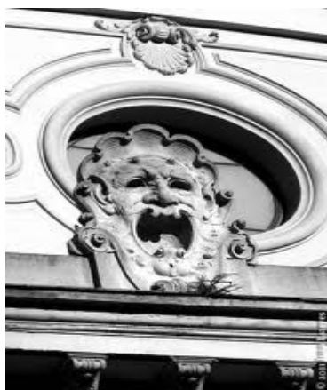
Figura 9 - Detalhe da Fachada do Teatro
