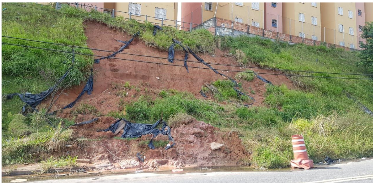
Figura 7: Situação inicial do talude.
