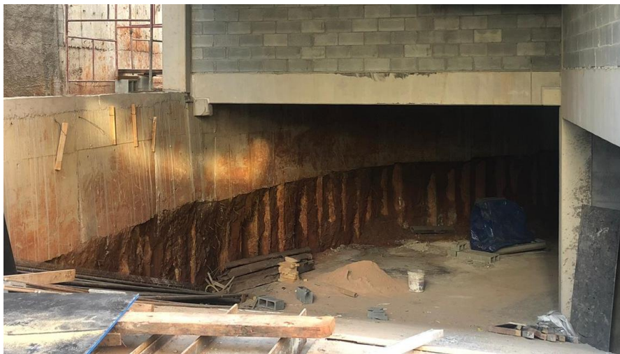
Figura 11: Visita à obra e análise das estacas justapostas já prontas.
