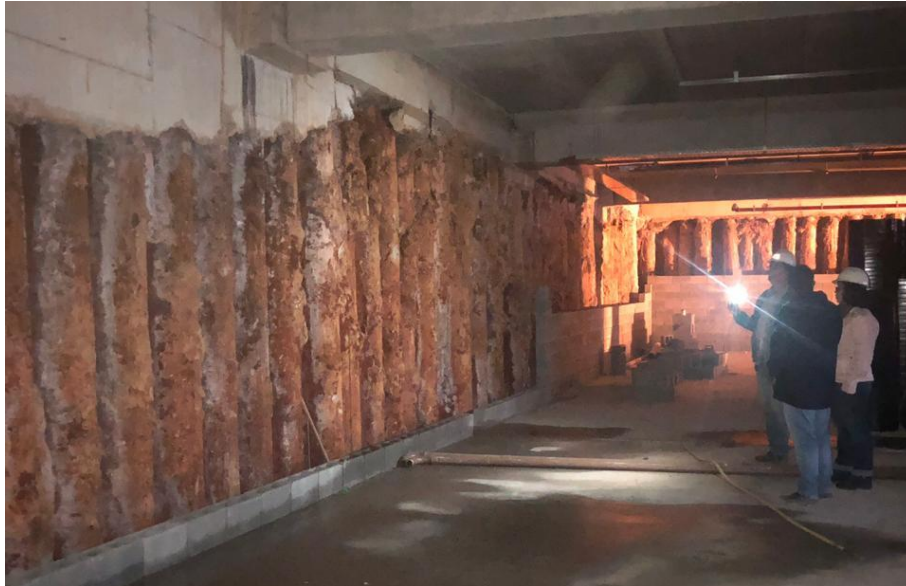
Figura 10: Visita à obra e análise das estacas justapostas já prontas.
