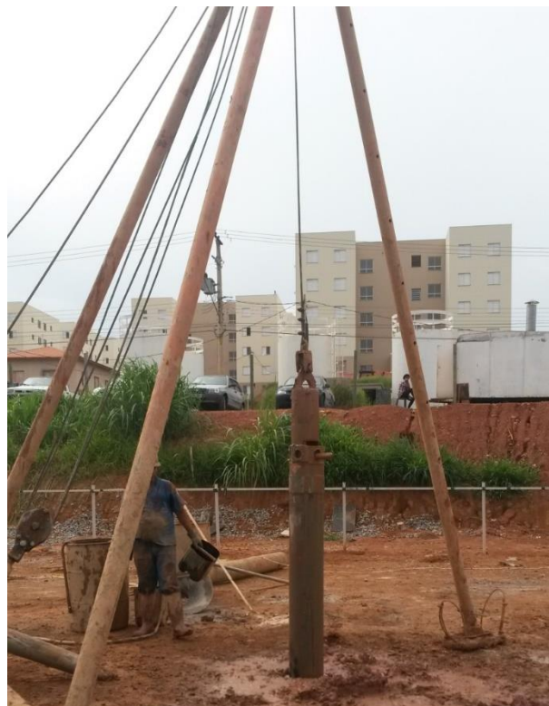
Figura 1- Escavação do solo com sonda e coroa.
