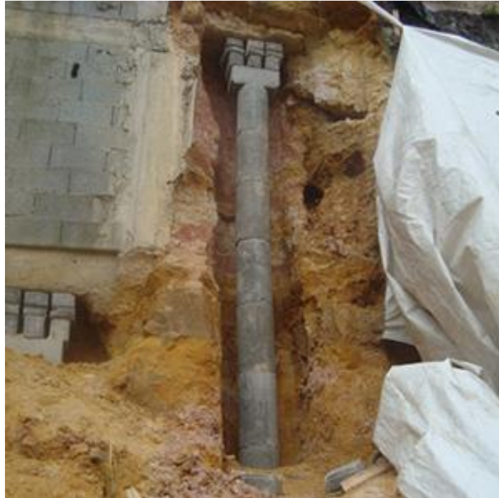
Figura 05 – Estaca Mega de concreto instalada.
