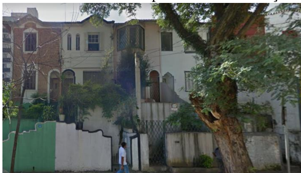
Figura 09 – Foto tirada antes do processo de demolição e limpeza.
