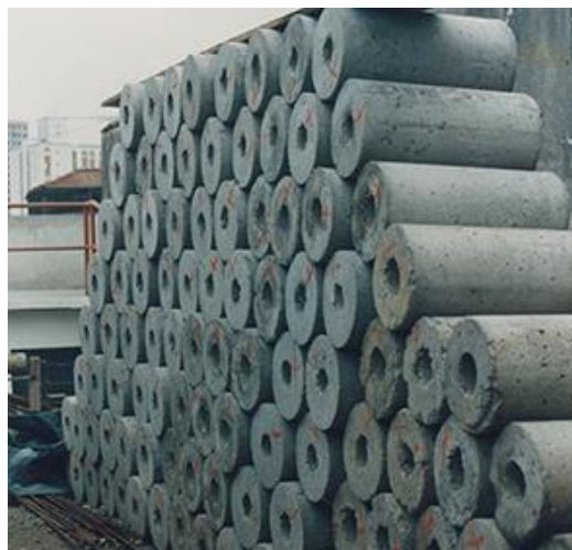
Figura 4 – Segmentos para estaca Mega de Concreto
