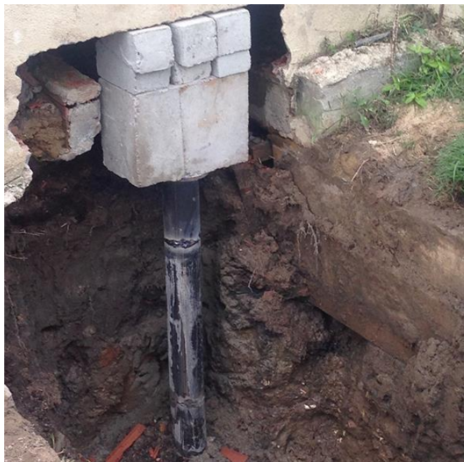
Figura 07 – Estaca Mega metálica instalada.
