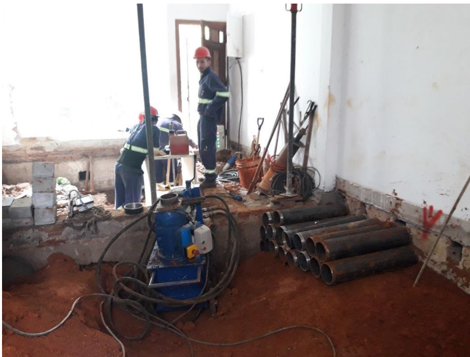
Figura 17 – Execução de estacas Mega metálicas na casa objeto de estudo
