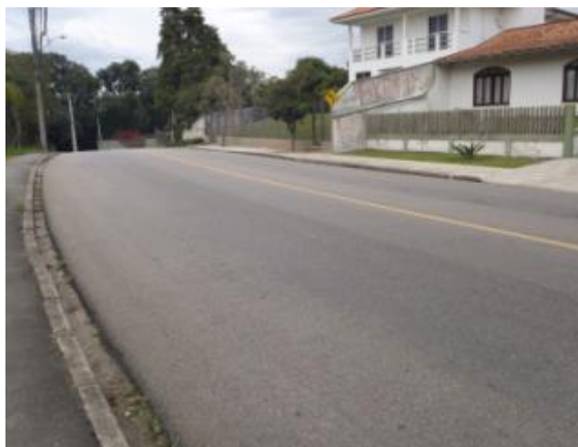
Figura 6 – Trecho sem Defeitos Asfalto Borracha.
