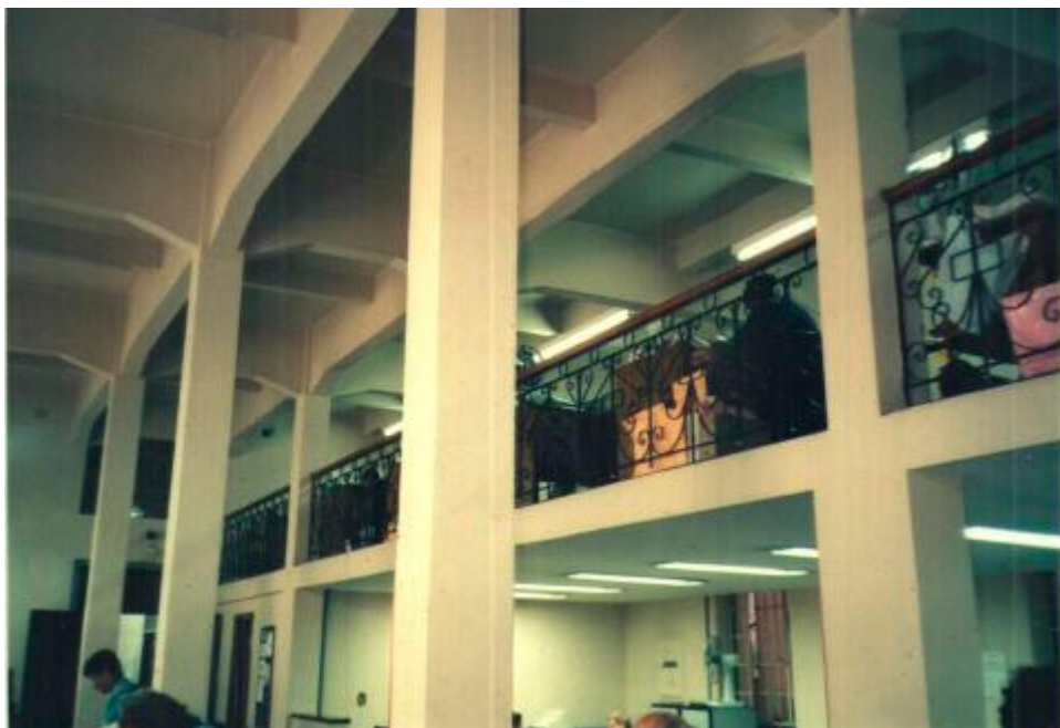
Figura 31: Imagem térreo após derrubada das paredes internas e criação de um novo nível. I nº 27943/CONDEPHAAT/90; p. 106. I Foto tirada por Vitor Campos.
